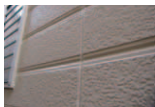
外壁の防水措置の状況確認
